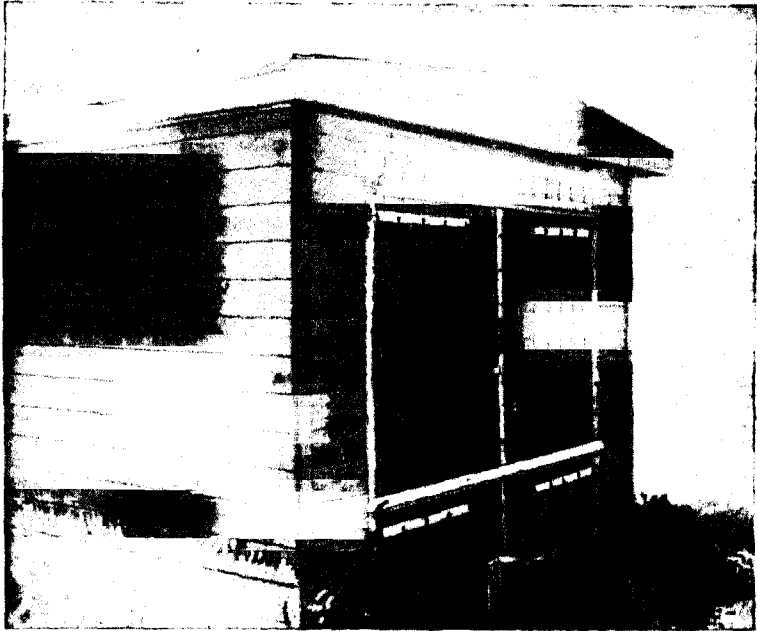
Fig. 9. Gaskammer aus Holz in einer Obstanlage in N. D. (Innen Sperrholzauskleidung). 4,77 m lang, 2,77 m breit, 1,98 m hoch; Inhalt rund 26 m 3 .
